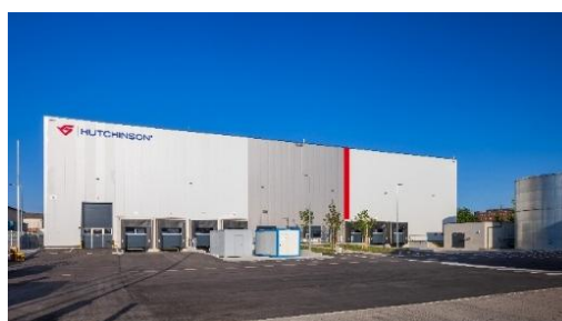
Centre de distribution de Mannheim ©Goldbeck
